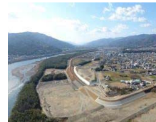
堤防工事が完了した脇町第1箇所
