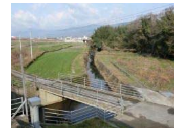
河川整備が進められる土井谷川
