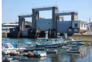
(改修事業着手前)
