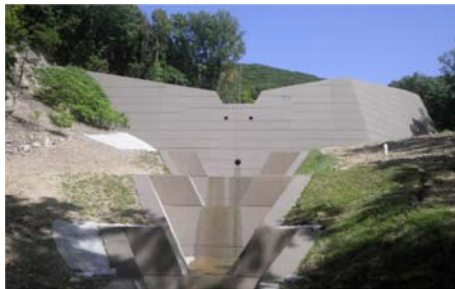
完成した堰堤
