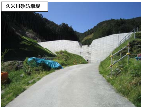
久米川砂防堰堤
