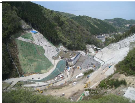
ダム本体施工状況
