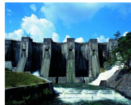
石積づくりの豊稔池ダム
