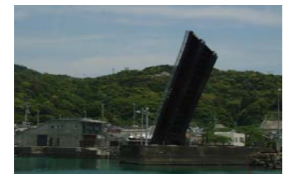
手結港可動橋
