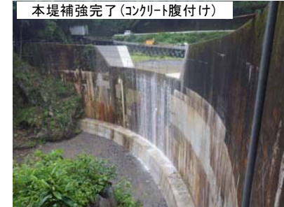
本堤補強完了(コンクリート腹付け)
