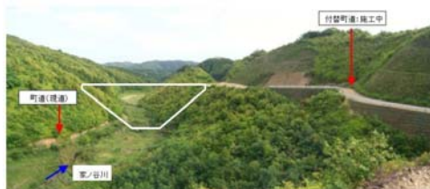
← ダムサイトを上流から望む
