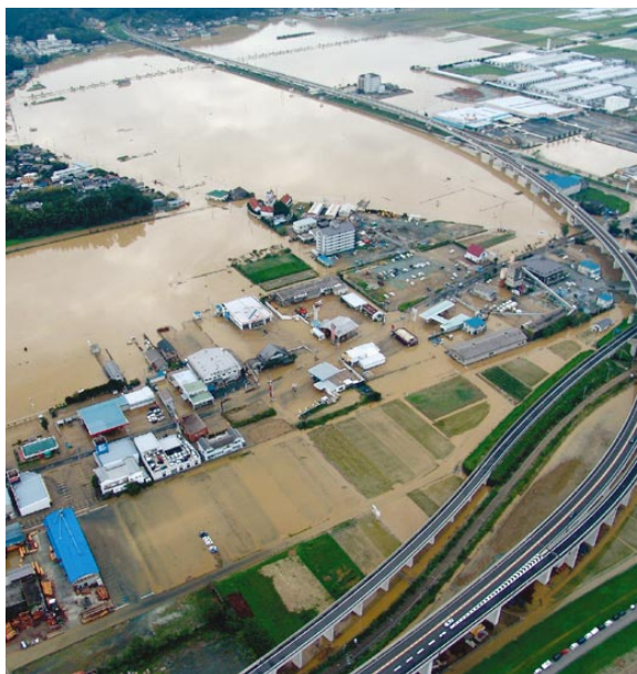
平成16年 台風16号による東大洲地域の浸水状況
