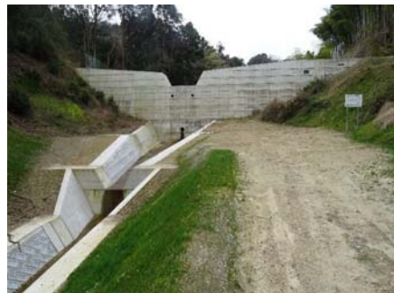
完成した堰堤
