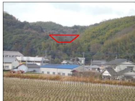
流域全景と保全対象
