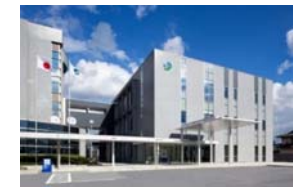
▲完成した危機管理センター
