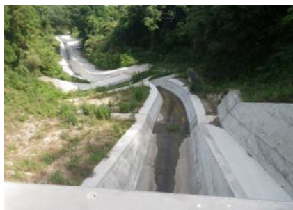
堰堤より下流の溪流保全工
