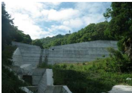
完成したえん堤
