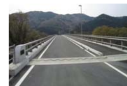
架替工事が完了した宇津橋
