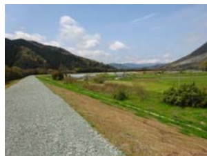
「池田成見地区」で完成した築堤
