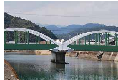
宍喰川「宍喰橋 (通称:かもめ橋)」
