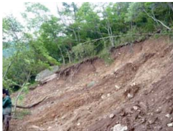
平成23年5月台風2号による斜面崩壊状況
