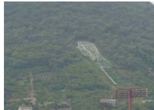
法面工・縦排水路 完成写真
