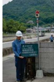
パトライト・サイレン設置
