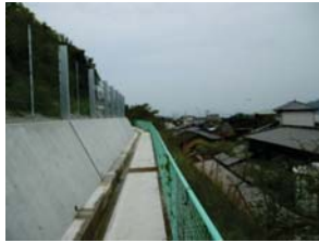
重力式擁壁・落石防護柵 完成写真
