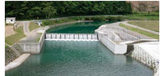
平串堰（可動堰）
