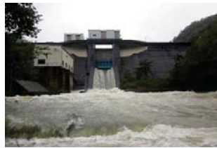
洪水時に放流する宮川内ダム
