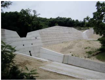
完成したえん堤
