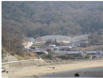
下流の保全対象を望む
