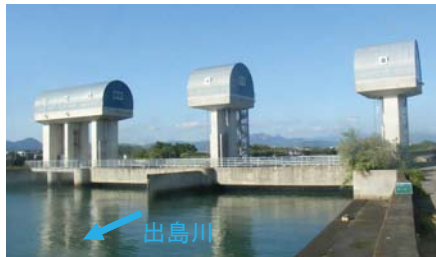
出島川水門 耐震補強工事完成
