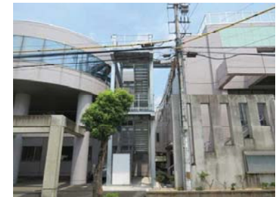
【役場庁舎津波避難階段】
