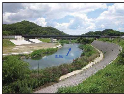
川北工区 改修状況
