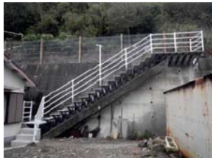
完成した串江地区避難階段（改築）
