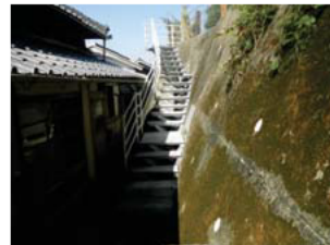
完成した鍋島(3)地区避難階段（新設）
