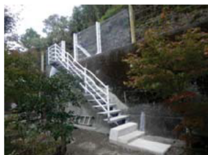
完成した鍋島(1)地区避難階段（新設）
