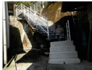
完成した津蔵測地区避難階段（改築）
