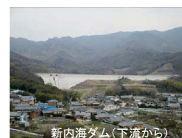
新内海ダム(下流から)
