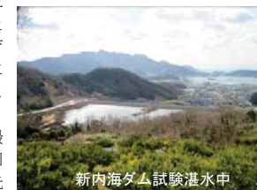
新内海ダム試験湛水中
