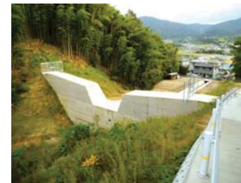
東岡川堰堤 (H26.10月) 東岡川通常砂防事業
