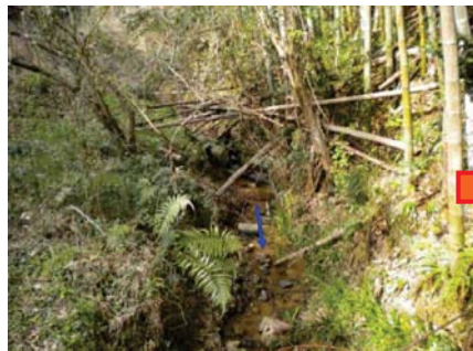
着工前(平成24年3月)
