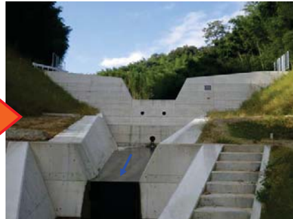
竣工後(平成26年10月)
