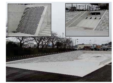
川岸雨水調整池【平成25年度完成】 (左上：流出渠、右上：流入堰)
