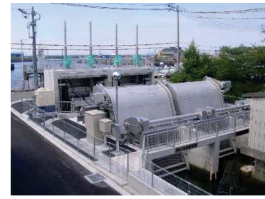
宮川ポンプ場【平成22年度完成】 (手前：除塵機、奥：ゲートポンプ)
