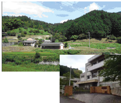
流域全景と保全対象(旧神山小中学校)
