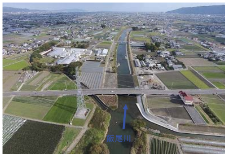
「加減堰 右岸」撤去後
