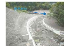
完成した池谷川溪流保全工
