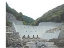
完成した池谷川砂防堰堤
