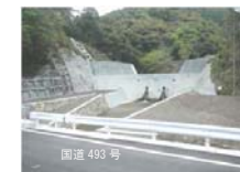
完成した寺谷川砂防堰堤
