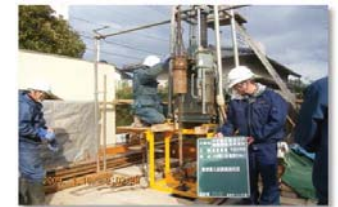
【地下水開発 井戸掘削】
