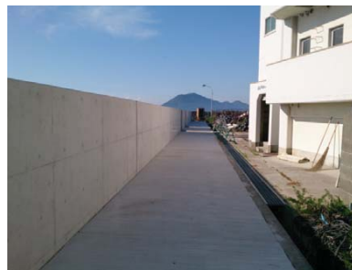
高潮対策事業（高松港の防潮壁）
