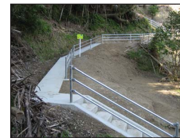
避難路整備工事 施工後
