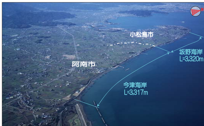
大型突堤 横堤上部工施工中 平成24年10月現在
