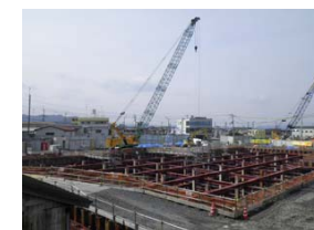
金磯南雨水ポンプ場建設工事の状況
