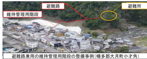
避難路兼用の維持管理用階段の整備事例(幡多郡大月町小才角)
