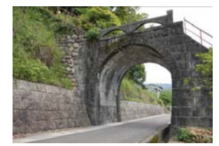
重要文化財『法恩寺跨線橋』
