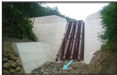
完成した砂防えん堤
