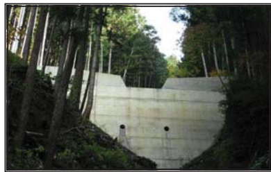
完成した治山事業による谷止工
