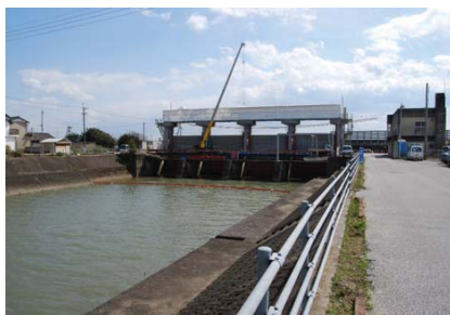
更新工事中の防潮水門
