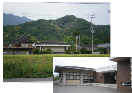
流域全景と保全対象(広域避難所)
