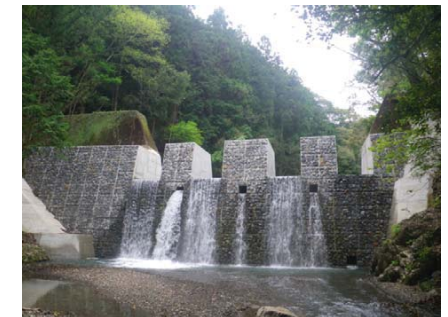
スリット化された長沢砂防堰堤
