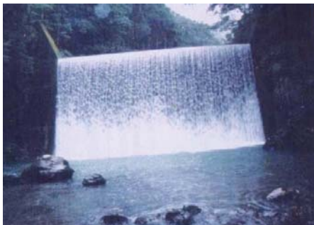
着工前の状況
