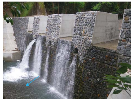
砂防堰堤のスリット化 完成
