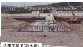
②施工状況(取水堰)
