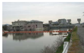
新池川排水機場
