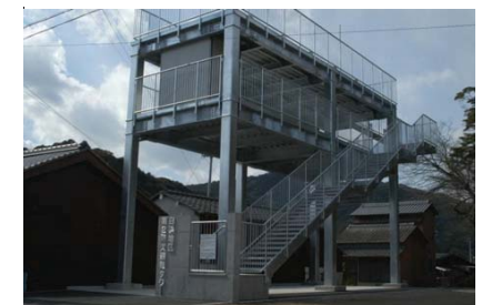
『白浜地区第2防災避難タワー』
