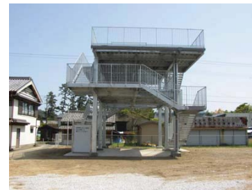
『白浜地区第1防災避難タワー』
