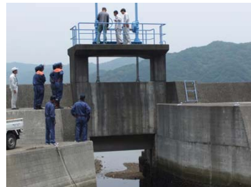
水門の点検実施
