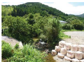
上流部の河道狭小部
