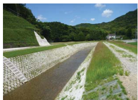
護岸・河道掘削の整備完了状況
