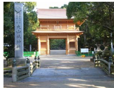
(688 年ぶりに再建された総門。(H22.4 完成)総檜造り、2 層構え 高さ 12m、幅 10m、奥行 5m)
