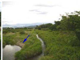
③未整備区間の状況 (桶田橋より上流を望む)
