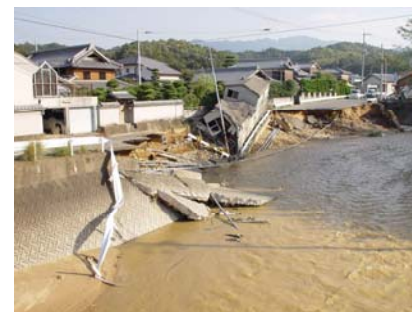
平成16年台風23号による護岸崩壊状況
