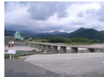
越水状況写真(平常時)
