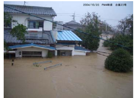
①台風23号による浸水状況(川島地区)
