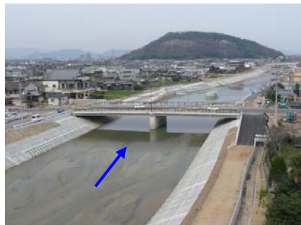
③整備状況(川島橋)
