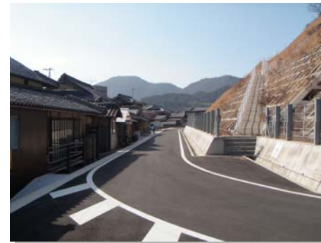
的場地区 (法面、市道、保全対象物件)
