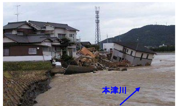
①平成16年10月台風23号出水による被災状況
