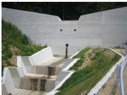
砂防えん堤完成状況
